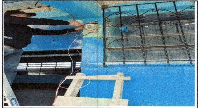
Foto 8: Reparación de sistema eléctrico
