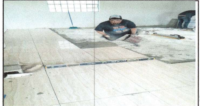
Foto 4: Sustitución de piso de torta de concreto por porcelanato
