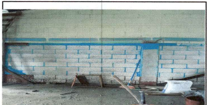
Foto 12: Reparación de repello y cernido en paredes (cuando aplique)
