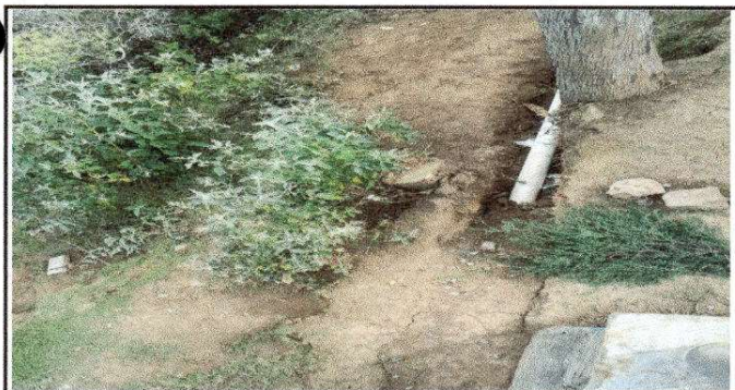
Foto 5: Sustitución de tubería PSI línea principal de aguas negras
