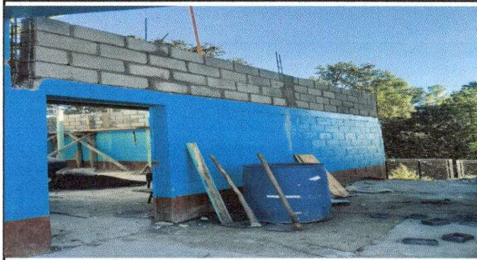
Foto 3: Sustitución de puerta.
