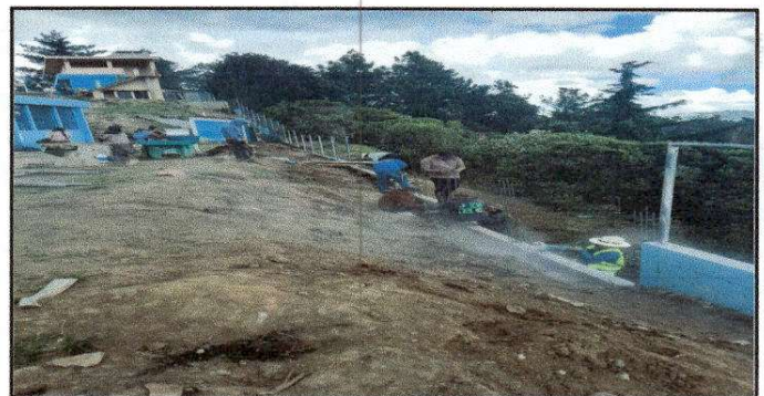
Foto 6: Reparación de muro perimetral de block
